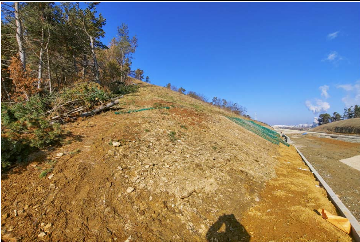
측면 사진(비탈면 STA.28+710~28+880)
