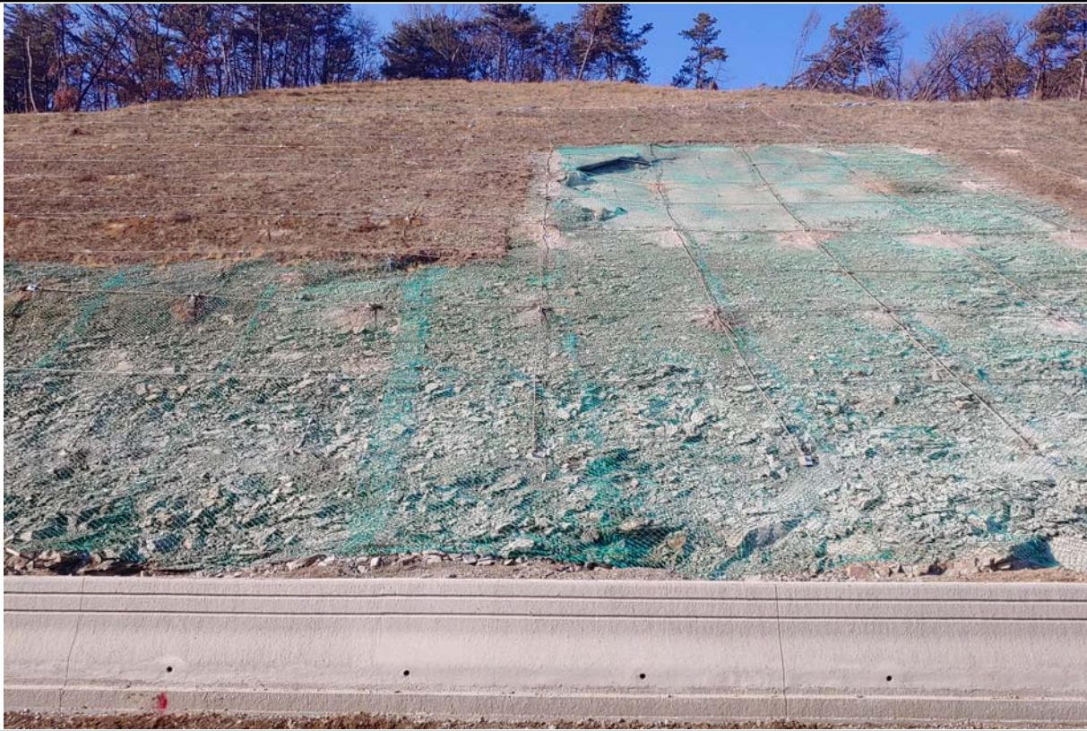
전경 사진(비탈면 STA.28+800~28+840)
