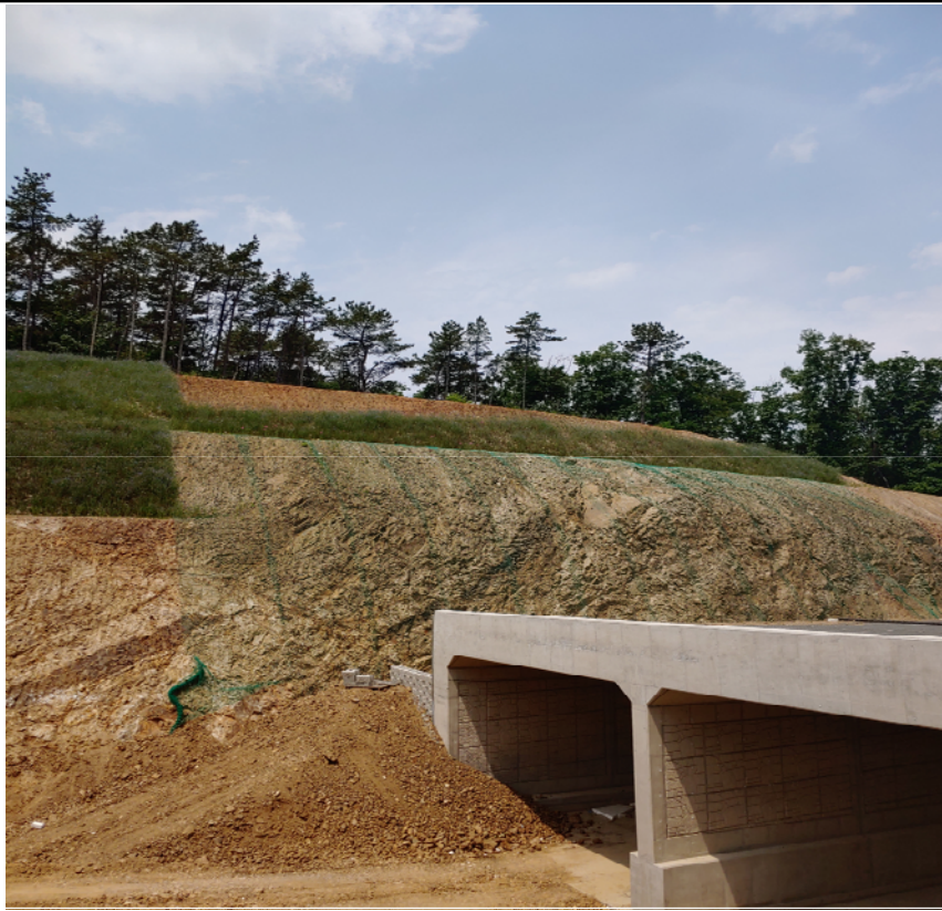
구간별 세부사진(비탈면 시점 STA. 31+140)
