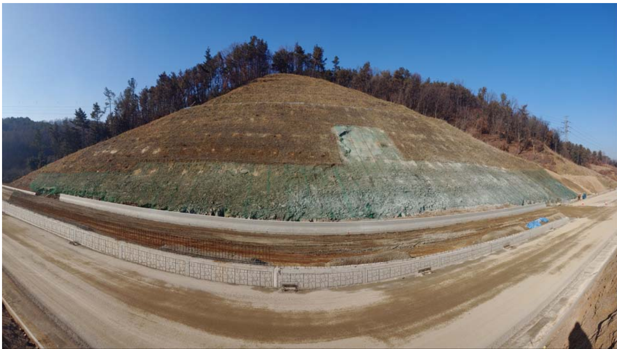
전경 사진(비탈면 STA.28+710~28+880)
