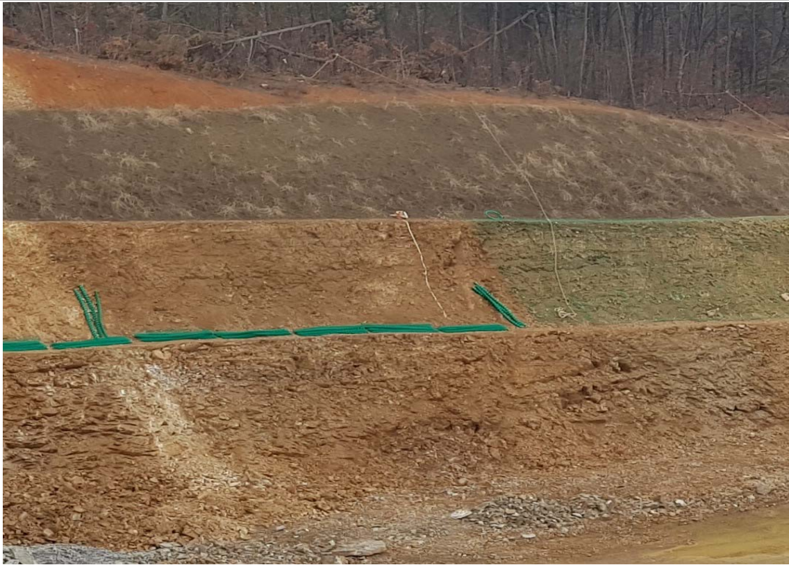
구간별 세부사진(비탈면 시점 STA.29+880)
