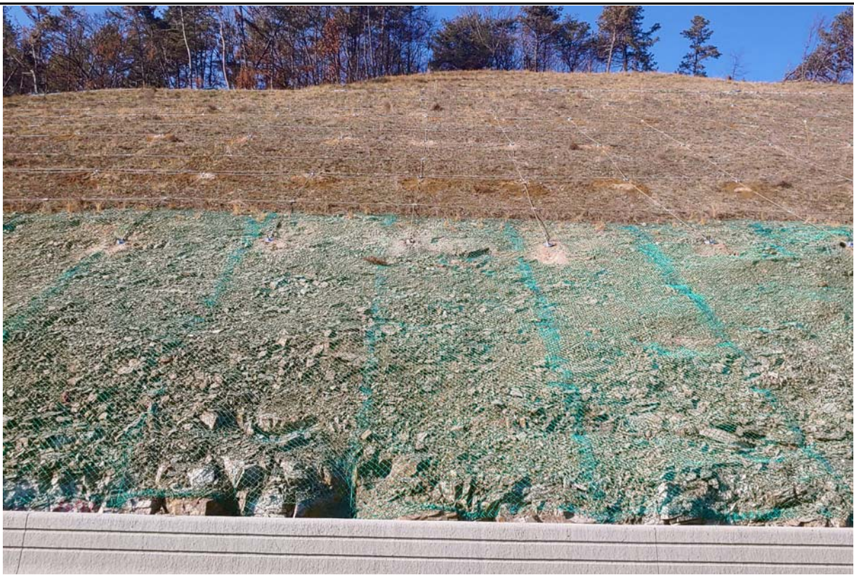
전경 사진(비탈면 STA.28+770~28+820)
